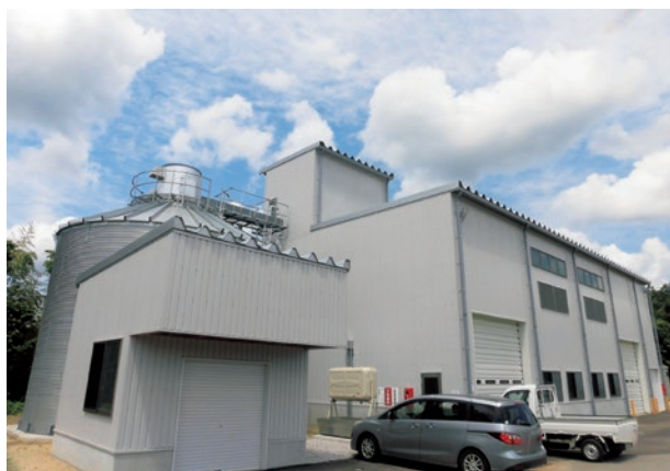
地域の乾燥・調製作業を担う新ライスセンター
